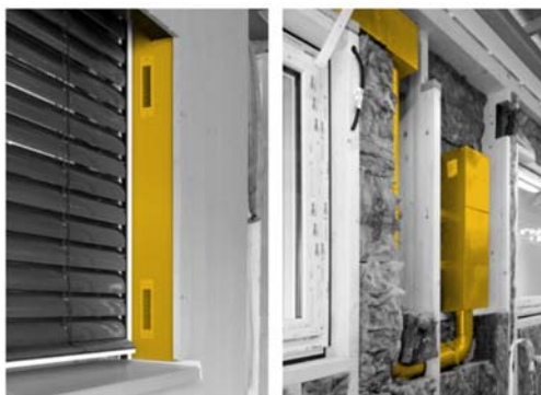
Abb. 58: Außenansicht des Lüftungsgeräts in der Laibung
